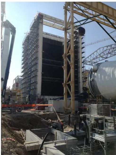
Fasi di realizzazione HRSG
