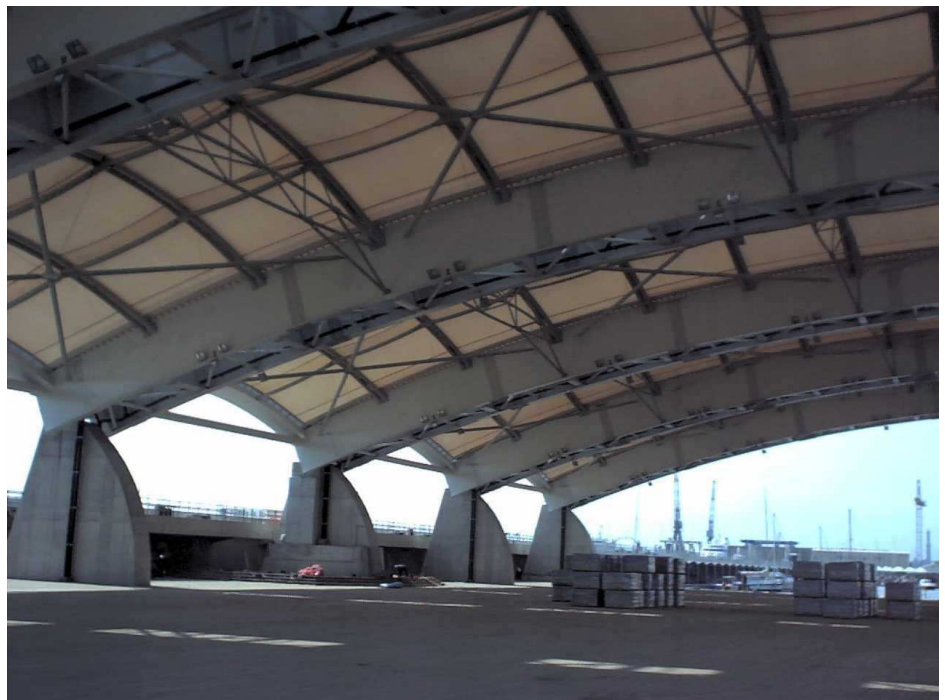
Vista dall'interno della copertura
