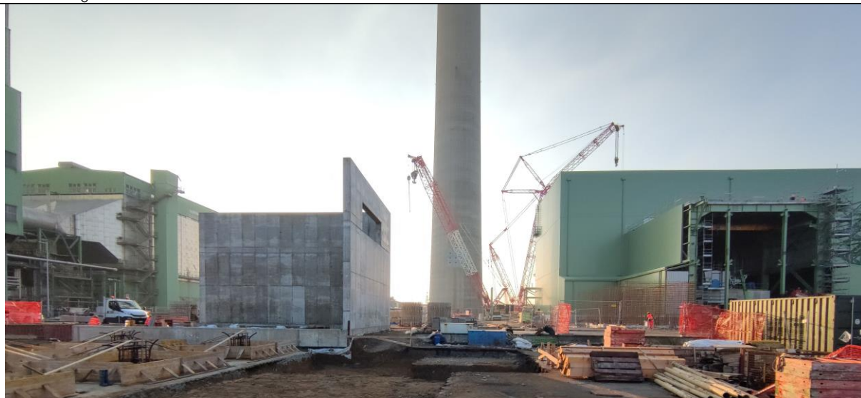
A sinistra la centrale esistente, al centro il camino alto 250 m e destra il nuovo edificio Tg con l'adiacente edificio Air Intake
