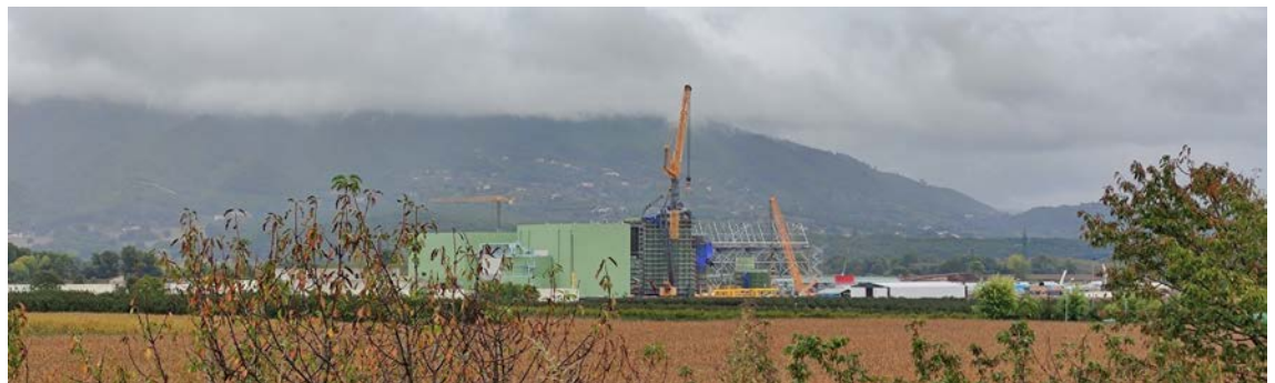
La centrale in costruzione
