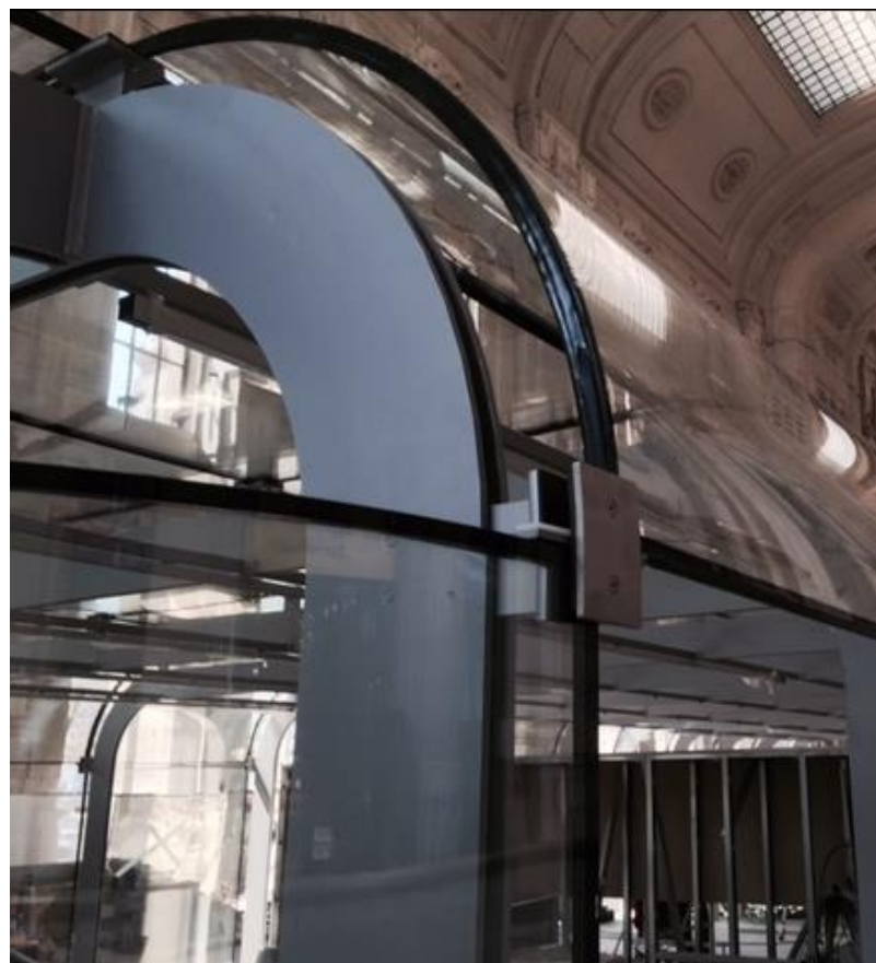
Box Centrali Particolare delle vetrocamere e delle finiture architettoniche
