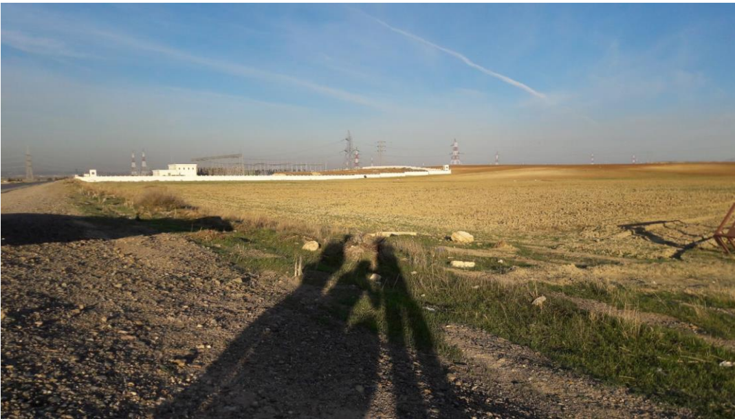
Vista della centrale dalla strada principale
