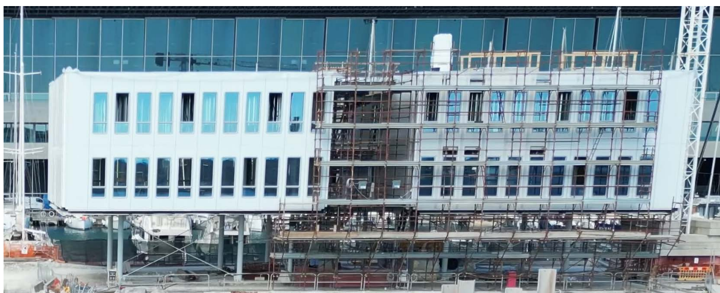
Fase di montaggio del vano scala
