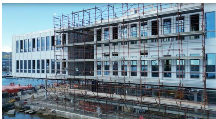
Fase di posa in cantiere
