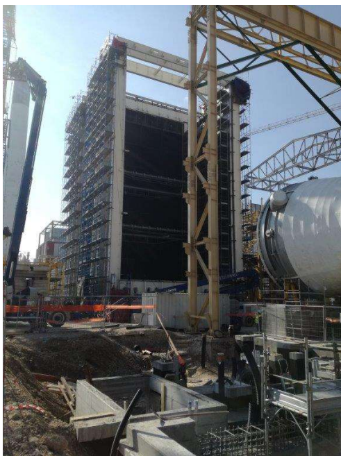
Phases of implementation HRSG
