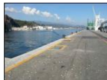
Vista della banchina 8-9-10 attuale
